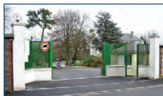
Entrée secondaire Accès, clôture et portail
